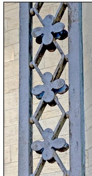
Le décor de fond, en fer plat, est donc celui d'une sorte de frise de losanges virtuels, losanges assez aplatis ici à Pupillin. En fait, il ne s'agit pas de losanges réalisés en tant que tels.
