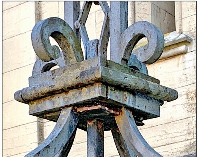
Un important dé ou mécanisme de liaison entre base et pied du croisillon vient serrer tous les fers ensemble. Il est constitué de plaquettes rectangulaires maintenues par un cordon torique. On peut voir, sur le cordon, des têtes de vis fixant les différentes pièces métalliques.
