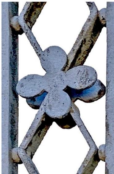
Ce décor est en effet obtenu par entrelacement de deux barres de fer plat laminé, barres régulièrement pliées ou coudées. Ces barres sont ensuite, soit assemblées "à mi-fer" au niveau des pointes saillantes des losanges.
