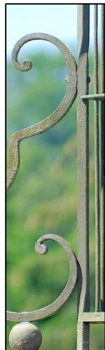
Chacune des faces du fût-cage comporte un décor de remplissage formé de quatre fines colonnettes en fer rond se terminant, en partie haute, par des agencements de style néogothique (voir plus loin). Ces colonnettes sont fixées à des traverses horizontales en bas, à mi-hauteur et en haut de la cage.
