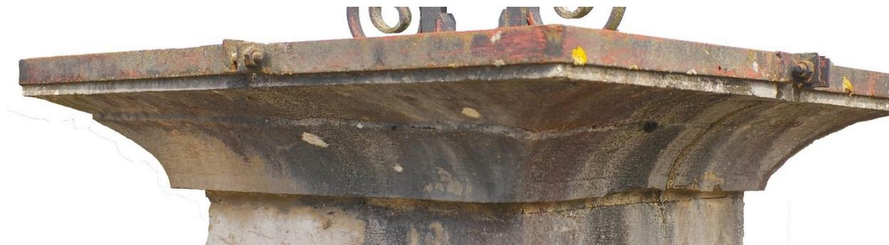
D'importantes fissures, l'une horizontale avec petit décrochement, l'autre verticale ont rendu nécessaire la pose d'une ceinture en fer plat.
