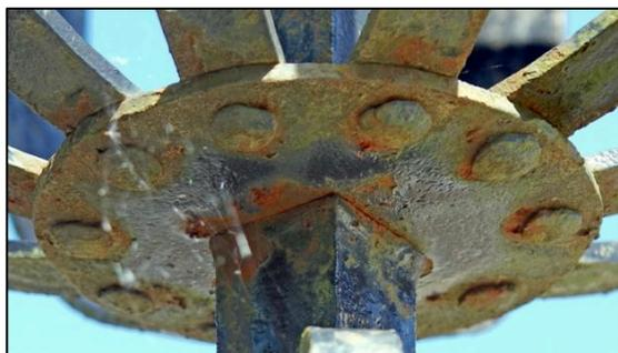
Les arceaux sont fixés, en bas et en haut sur des platines formées de coupoles sphériques. De puissants rivets assurent l'assemblage des arceaux sur les coupoles, en bas et en haut.
