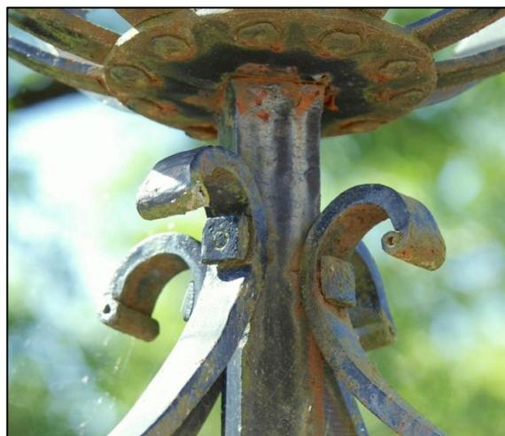
On voit aussi sur ces clichés comment les arceaux du globe sont fixés par de forts rivets sur la platine circulaire reposant sur le cran d'arrêt de la barre porteuse.
