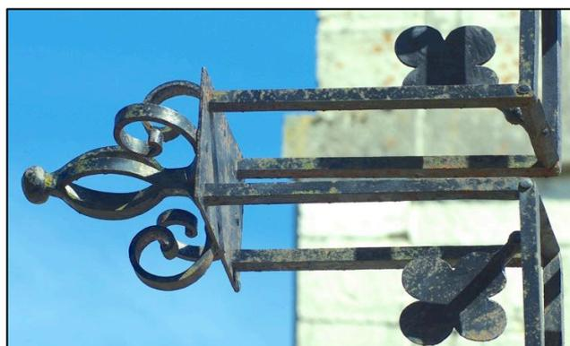
De fines platines carrées servent d'une part à fixer les extrémités des fers structurels (assemblages par rivets) et d'autre part à recevoir et fixer les fleurons d'extrémité.
