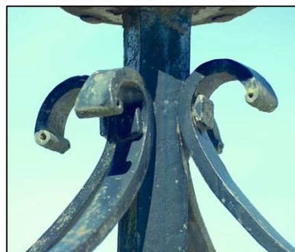
Un examen attentif au téléobjectif du haut de la barre structurale, au-dessus des consoles, montre que la section de cette barre a été légèrement élargie, de façon à constituer un palier d'arrêt servant à éviter la descente du globe surmontant les consoles
