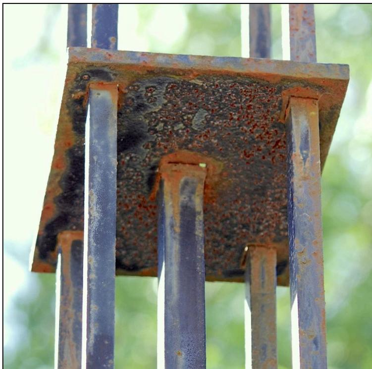
Pourtant, et de façon étonnante, le croisillon sommital commence juste au-dessus du globe avec ses quatre fers verticaux de section carrée, plus petite que celle de la barre centrale. Ces quatre fers formant les angles du fût-allonge parallélépipédique (structure 3D) passent à travers les trous ménagés dans la platine supérieure.
