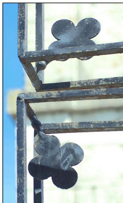
Cette disposition angulaire permet de placer sur les entretoises, et au-milieu de celles-ci, des décors quadrilobés. Le dispositif technique employé ici est remarquable.
