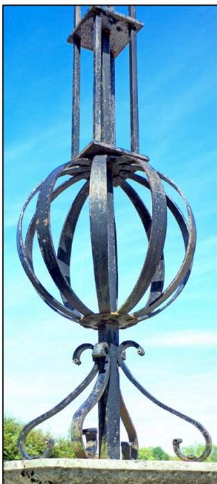
Un puissant et unique fer de section carré constitue la colonne vertébrale du pied ou la partie basse de la croix. Ce fer porteur se retrouve dans les trois étages ou modules se superposant : module aux consoles, module à globe, module à fût-allonge.
