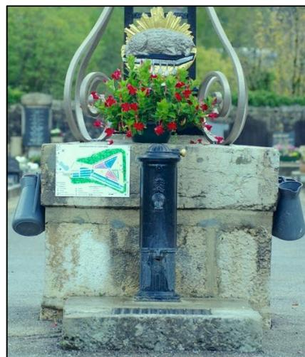
Il n'est plus question du piédestal originel, de forme hexagonale et élevé sur un emmarchement à trois degrés, tel que l'architecte Comoy l'avait projeté et fait réaliser en 1851. Le socle est désormais un monumental massif en blocs de pierre appareillés formant un parallépipède rectangle allongé, avec une partie supérieure saillante (un beau bloc monolithique).
