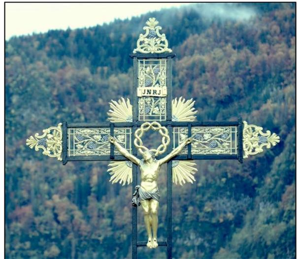
Outres les barrettes moulurées terminales, les extrémités des branches libres s'achèvent par des culots en fonte moulée reprenant la thématique de la vigne à laquelle vient s'ajouter celle des épis de blé. L'ensemble de ces décors en fonte est vissé et boulonné sur les fers structurels.
