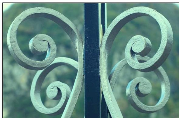
Les noyaux des volutes ou rouleaux sont forgés de façon plutôt rudimentaire (sans amincissement terminal des fers plats). Les fers sont tordus pour permettre leur fixation sur les montants de la croix de façon à compenser la rotation de 45° entre les faces ou profils des deux sortes de fers.
