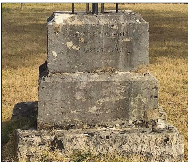
Le socle en pierre sur lequel est scellée la croix est effectivement atypique, avec un style sans fioriture. Il repose sur une première dalle en pierre de section carrée. Au-dessus de celle-ci sont superposés deux blocs massifs, de forme parallélépipédique sur plan carré et de largeurs différentes, sans corniche.
