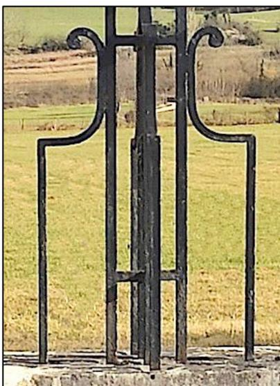
La croix est soutenue en pied par quatre consoles en fer de section carrée, placées sur les axes principaux de la croix (et non pas sur les diagonales du piédestal comme c'est souvent le cas).
