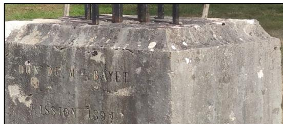
Les arêtes du bloc inférieur sont chanfreinées alors qu'un cavet renversé est réservé en partie haute du bloc supérieur (se substituant au chanfrein de l'étage inférieur).
