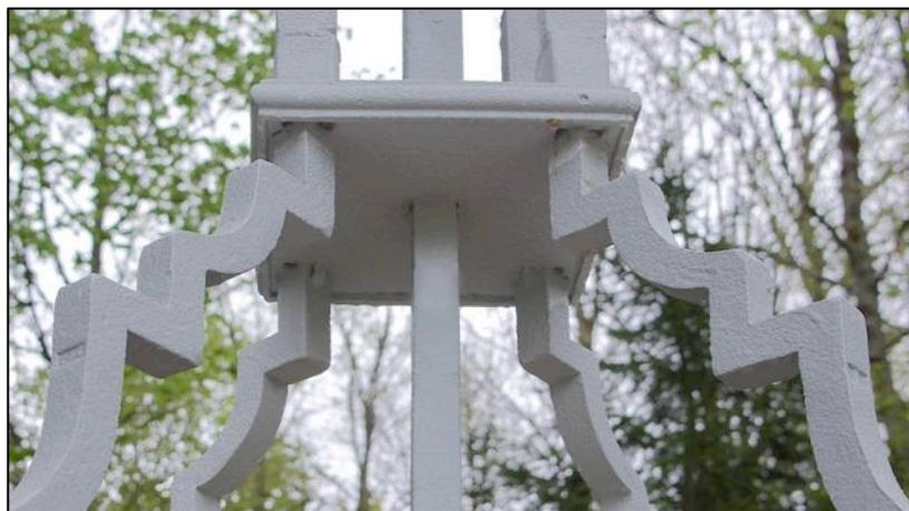
En partie basse, le fût intermédiaire se lie aux consoles par l'intermédiaire d'une platine métallique à tore cylindrique externe.
