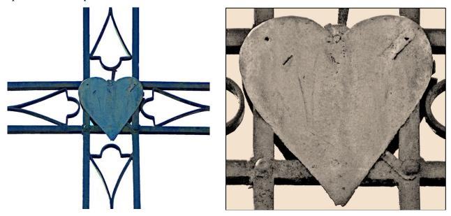
On peut noter sur la vue au téléobjectif que le croisement et l'assemblage des fers structurels se font à "mi-fer" avec blocage de la fixation par des rivets ou vis à tête ronde.
