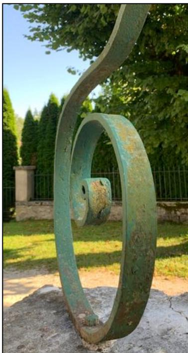
En partie haute, les fers des consoles sont solidarisés avec la tige montante grâce à des colliers à baguette. Ces fers plats sont fixés, en bas, à la corniche par boulonnage. Quant à la tige centrale, elle est scellée dans la pierre du piédestal.
