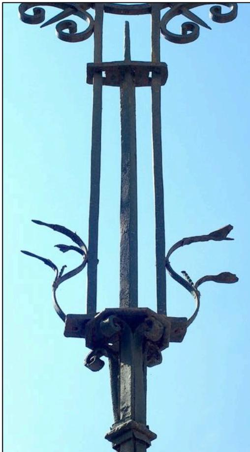
Les deux petits fers extérieurs et la grosse tige centrale sont fixés, à la base, sur une platine rectangulaire, elle-même solidarisée à la platine octogonale terminant le fût. En partie haute, les deux fers extérieurs et la tige centrale passent à travers les ouvertures ménagées dans une autre platine approximativement rectangulaire, platine qui va servir d'entretoise. La tige centrale se termine alors par une petite pointe de section cylindrique.
