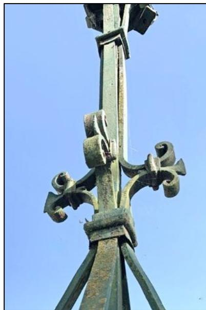
Tout le dispositif du bas de la croix (console, gaine du fût intermédiaire) répond au besoin de renforcement et de stabilisation mécaniques d'une croix très haute se développant autour d'une tige-pivot centrale.
