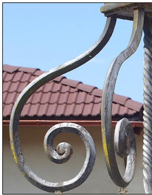
D'importants rouleaux, écartés de la tige centrale montante sont positionnés sur les diagonales de la corniche du piédestal. Les consoles sont fixées à la corniche par l'intermédiaire de grosses perles en fer étampé.
