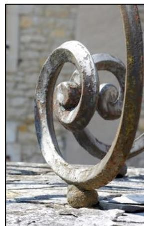
Un autre avantage de cette solution “*sur angle*” est de nature technique. Après leur mouvement spiralé, les fers de section carrée des rouleaux changent de courbure, se redressent verticalement et viennent se fixer dans les angles d’une platine-entretoise.
