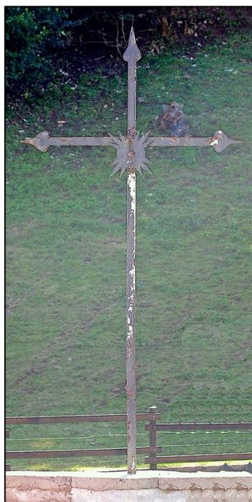
La croix est en fer plat avec deux montants simplement superposés. Ils sont fixés l'un à l'autre par simple boulonnage.
