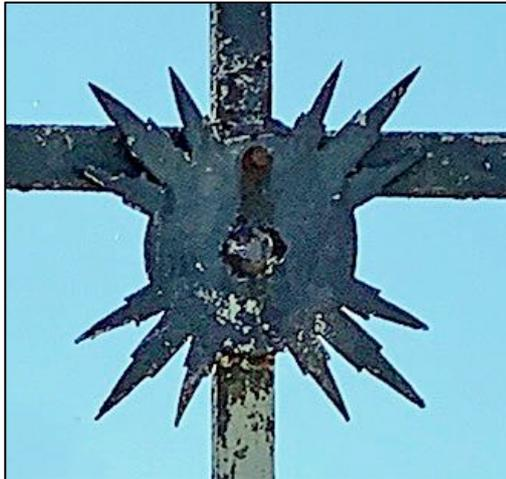
Un motif représentant une couronne de rayons de gloire, en tôle de fer découpée, est placé au cœur de la croisée. Il est simplement fixé par un boulon au montant vertical.
