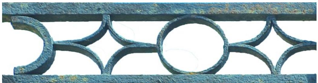
Les anneaux circulaires et les as de carreaux sont réalisés en fer plat. Ces derniers sont fixés aux anneaux par de discrets rivets.
