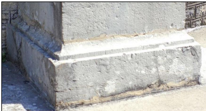
La base, autre bloc monolithique, est assez simple. Elle présente une haute plinthe surmontée d'un petit réglel puis d'un quart de rond finissant en s'alignant sur les faces du dé. Des réagréages récents sont visibles ici et là.
