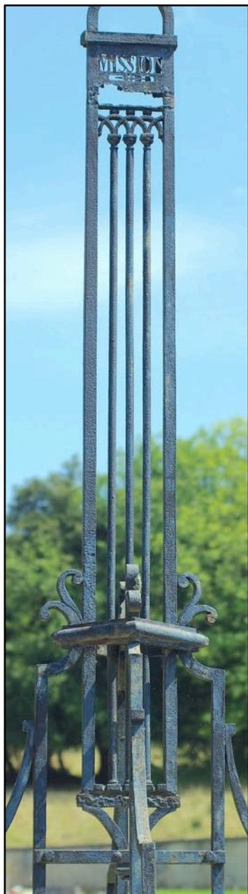
Le fût se caractérise essentiellement par un décor de remplissage en forme de remplage néogothique ogival réalisé à partir de trois très longs fers ronds (trois colonnettes détachées).
