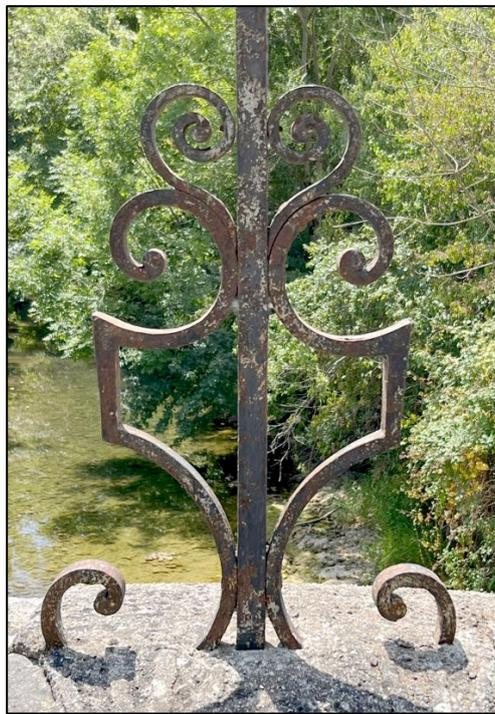
Les consoles, réalisées en fer plat, sont de forme globale en S. Elles comportent un gros rouleau en partie basse et un plus petit à courbure inversée en partie haute, les deux enroulements étant reliés entre eux par une partie strictement verticale (avec point de rebroussement original). Les consoles sont fixées à la barre porteuse par de discrets rivets.
