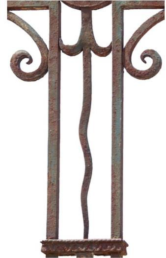
Le motif décoratif est fixé, à l'intérieur, sur un anneau au centre de la croisée et vient s'appuyer, vers l'extérieur, sur la barrette d'extrémité. On note que celles-ci sont en fer étampé avec le même décor dentelé et ondulant que celui décrit précédemment.
