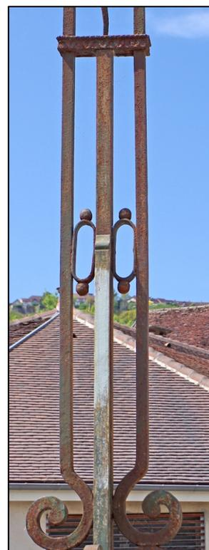
En bas du pied, les fers carrés sont forgés de façon à former de belles volutes venant se positionner contre la barre structurale centrale et s'appuyer aussi sur les volutes des consoles.
