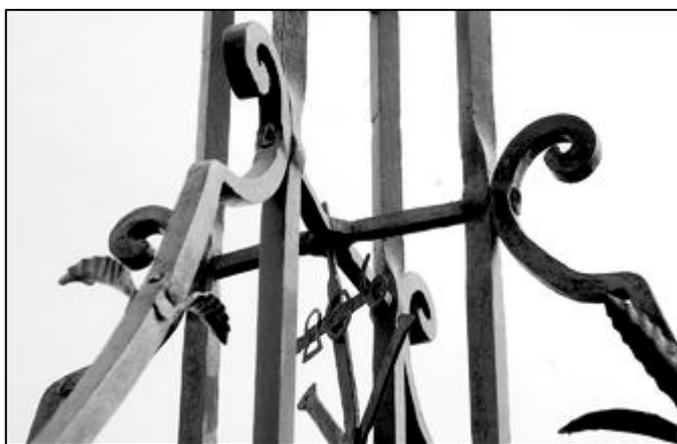
Au niveau du croisillon haut, est opérée une torsion à 45° des fers verticaux des montants du fût. En partie basse du fût, les faces de ces fers sont orientées selon les diagonales de l'ancien piédestal pour permettre la fixation des consoles. Au dessus du croisillon, les faces des fers (après torsion à 45°), s'orientent parallèlement à l'ancien piédestal pour pouvoir mettre la croix sommitale en bonne position.
