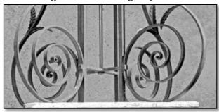
Les consoles sont fixées par boulonnage aux fers des montants verticaux du fut. L'assemblage se fait au niveau de deux croisillons d'entretoisement. Les fers ascendants ont alors leur faces orientées selon les diagonales du fût.
