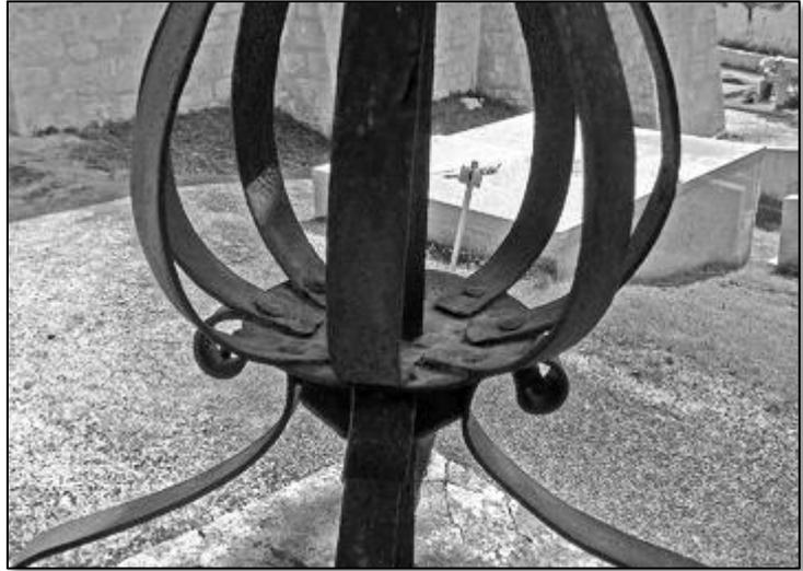
Les fers plats du balustre sont rivetés à la base sur une coupelle sur laquelle viennent aussi s'appuyer - par en-dessous - les fers des consoles. À noter la présence de la tige verticale en fer de section carrée montant depuis le piédestal et traversant le pied et le balustre intermédiaire.
