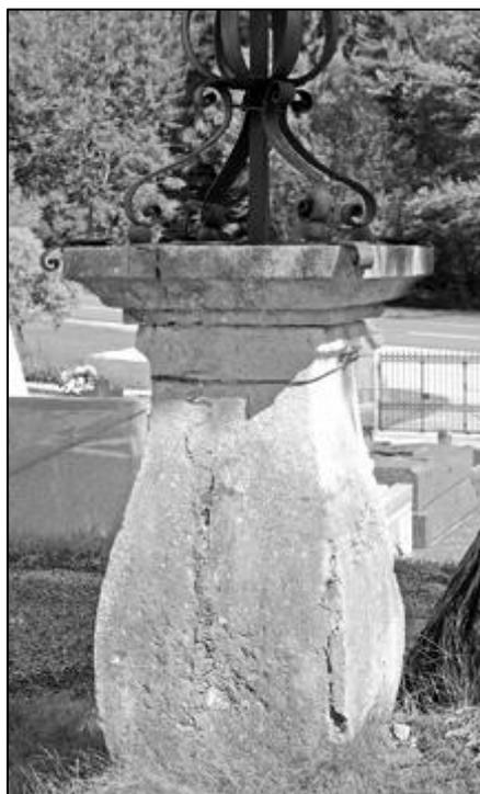
La partie ferronnée de la croix vient s'ancrer de façon sophistiquée sur la corniche du piédestal avec un croisillon de fers plats positionné selon les diagonales de la corniche (fers se terminant par des volutes vers l'extérieur). Un important fer de section carrée montant au centre du dispositif est sans doute enfiché dans le bloc de pierre.
