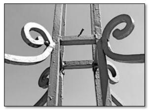
Les fers verticaux du fût ont leurs faces orientées parallèlement aux faces du piédestal et ne nécessitent donc pas de torsion à 45° à mi-hauteur du fût (comme c'est généralement le cas pour les croix anciennes), d'où la fixation des volutes dans l'angle des fers verticaux (dispositif de fixation forcément assez maladroit et fragile).
