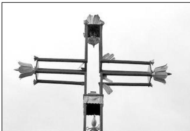
À noter, d'un point de vue structurel, que l'on a dégagé le volume au carrefour des branches de la croix. Des barres de liaison relient les faces avant et arrière des branches, mais aucun entretoisement vertical n'a été prévu.
