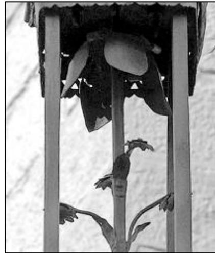
La partie supérieure du fût se termine par un petit lambrequin en tôle découpée et par un dé métallique (en mauvais état) assurant la liaison entre le fût et la croix sommitale. Des angles du dé métallique jaillissent vers l'extérieur quatre fleurs à deux tiges (avec des calices faisant penser à des narcisses).
