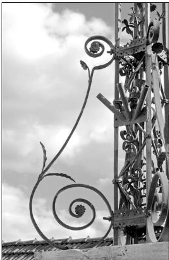
Les consoles, composées de deux rouleaux à courbures inversées, sont relativement simples (pas de redan intermédiaire très marqué, mais simple brisure de ligne). Des duos de feuilles d'eau en tôle estampée sont disposées, en bas, au sortir des gros rouleaux.
