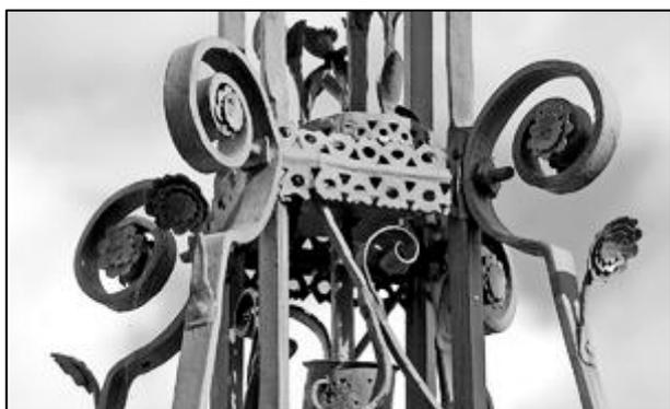
En partie basse et en partie haute, au niveau des points d'attache bas et hauts des consoles, on note la présence de plaques en tôle découpée (petits lambrequins) cachant largement le dispositif structurel d'entretoisement assurant la rigidité de la croix métallique.
