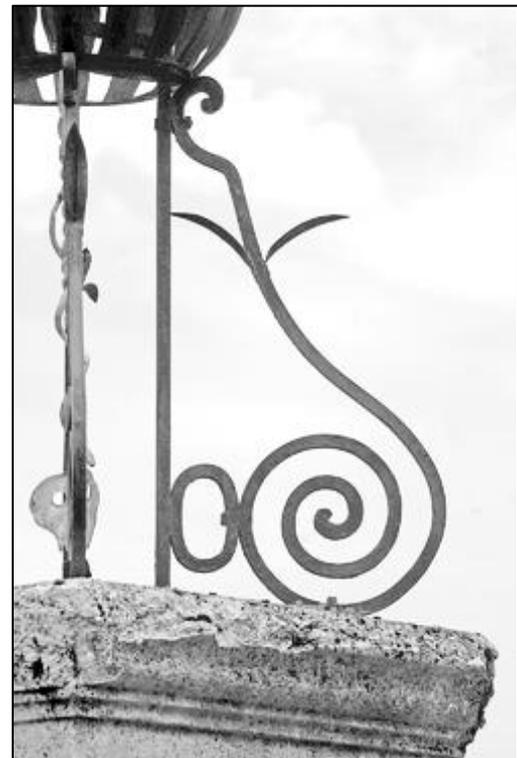
Les consoles sont fixées par boulonnage sur les montants verticaux de cette partie basse ou pied du fût. Les montants du fût sont réalisés en fer de section carrée. L'orientation des profils de ces fers se fait selon les axes diagonaux de la corniche, ce qui permet la fixation des fers des consoles dont les plans sont ceux des diagonales du piédestal. Plus haut - à l'intérieur du globe - , les fers changent d'orientation avec une torsion à 45%.
