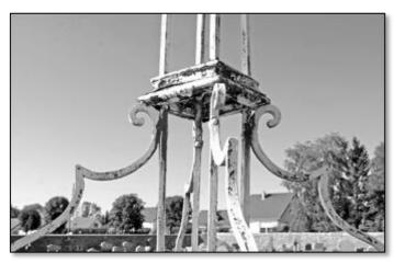
Au-dessus des consoles, a été positionnée une structure ou plate-forme intermédiaire pleine, avec des moulures, à partir de laquelle partent les quatre fers verticaux de la seconde partie du fût. Il n'y a pas continuité de structure des fers verticaux, pas plus que de torsion à 45° de ceux-ci. La plate-forme vient ici gérer la discontinuité structurelle.
