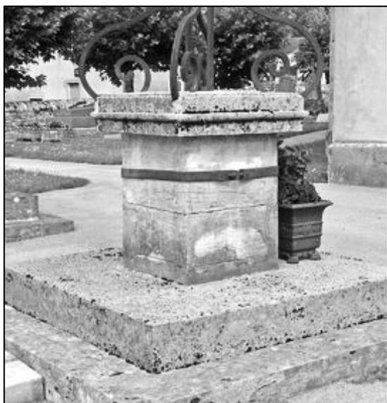
Le premier degré de l'embranchement est en calcaire. Lui a été superposé un second degré en béton cellulaire.
