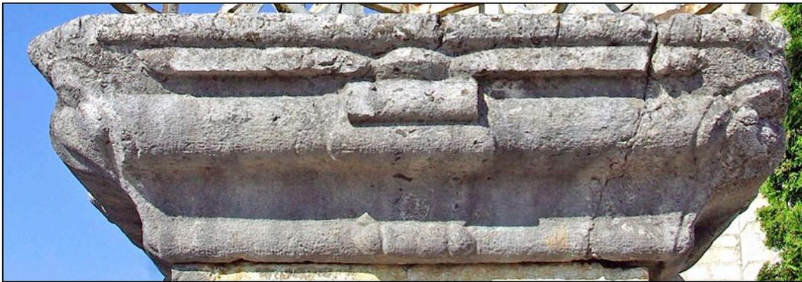
La modénature de la corniche est assez complexe, comportant plusieurs courbes et contre-courbes (cavets, tores, doucines...) surmonté d'un réglet et d'une baguette ronde.
