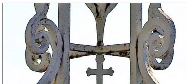
L'orientation des faces des fers montants correspond aux axes diagonaux du piédestal ce qui rend plus aisée la fixation des fers des consoles dont les faces sont parallèles aux diagonales de la corniche. Plus haut, à l'intérieur du globe, les fers montants devront changer l'orientation de leurs faces et subir une torsion à 45%.
