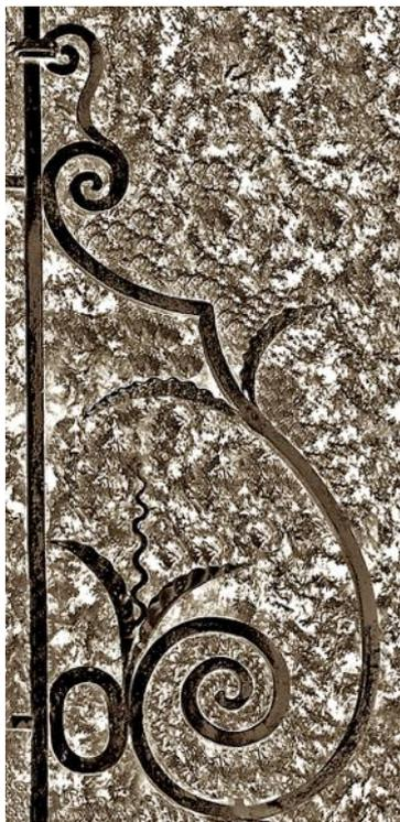
Tout en bas des consoles, des anneaux ou ovales aplatis en fer forgé sont intercalés entre les rouleaux inférieurs et les montants verticaux, donnant plus de grâce à cette structure de soutien.
