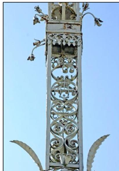
À noter la présence de barres transversales immédiatement au-dessus du globe, renforçant la structure du fût et accentuant aussi l'impression de fermeture de la cage.
