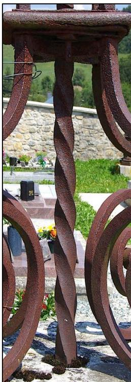
D'importants rouleaux, en fer de section carrée, écartés de la tige centrale montante, sont positionnés sur les diagonales de la corniche du piédestal. Les consoles ainsi placées donnent la meilleure assise possible à la croix.
