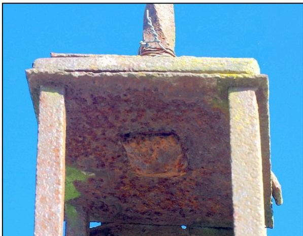
En partie haute du fût intermédiaire, les fers sont soudés à une platine carrée de faible épaisseur. Celle-ci est ensuite solidarisée à la platine basse du pied du croisillon avec une 3<sup>ème</sup> platine intercalée, plus épaisse et prise en sandwich, formant joint-amortisseur.
