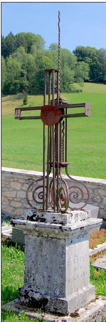
De style Restauration, la croix comporte plusieurs parties étagées et bien distinctes (trois modules indépendants), avec une base à quatre consoles, un fût intermédiaire et un haut croisillon. Ces modules sont solidarisés entre eux par boulonnage, ce qui permet de monter et démonter aisément la croix.
