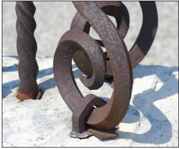
La base de la croix en fer forgé, à l'allure assez surbaissée, comporte quatre consoles d'un style bien particulier et une puissante tige centrale torsadée (typique du modèle des croix ALS). L'ensemble permet de bien transférer le poids de la croix sur le piédestal et d'assurer aussi la stabilité au renversement.
