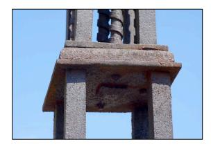
En partie haute du fût intermédiaire, les fers sont soudés à une platine carrée de faible épaisseur.
