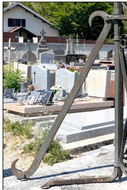
En partie haute les volutes des consoles sont fixées à une ceinture enserrant le fût et ses quatre montants structurels. Des étriers ont été aménagés aux différents angles de la ceinture de façon à permettre la fixation des consoles par des clavettes.
