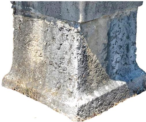
Le bloc inférieur est un parallélépipède de section carrée. Il présente une base formée d'une plinthe à laquelle succède un cavet renversé. La courbure du cavet va en s'atténuant progressivement en remontant vers le haut. La pierre ne semble pas avoir été finement bouchardée mais l'érosion du calcaire a peut-être fait disparaître l'état de surface d'origine.
