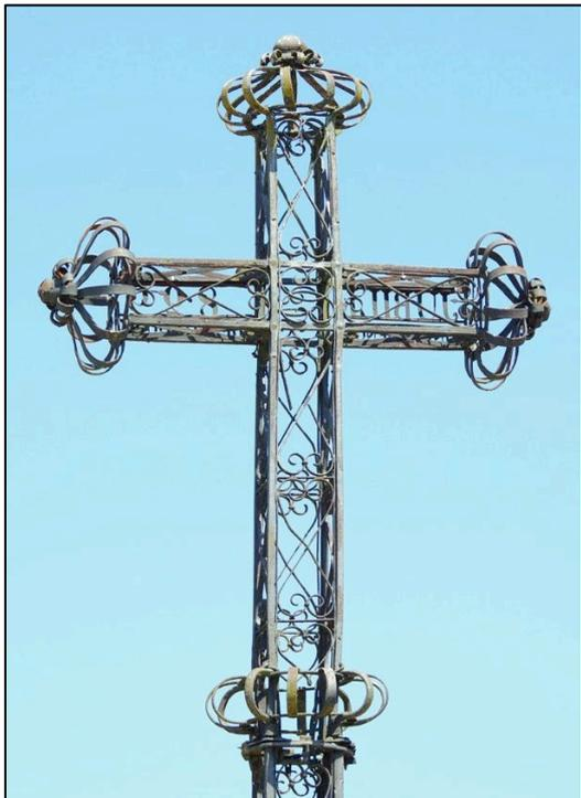
Ce croisillon est réalisé de la même façon que le fût avec quatre fers structurels carrés formant les montants du pied et des branches libres.
