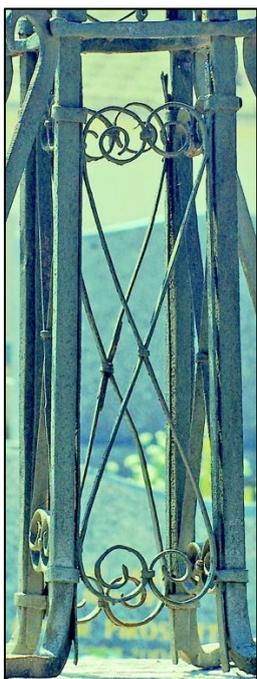
Au-delà de la ceinture d'attache des consoles, le pied du fût se prolonge en continuité avec la partie haute du fût. Le décor des faces du fût y est du reste identique (à quelques détails près).
