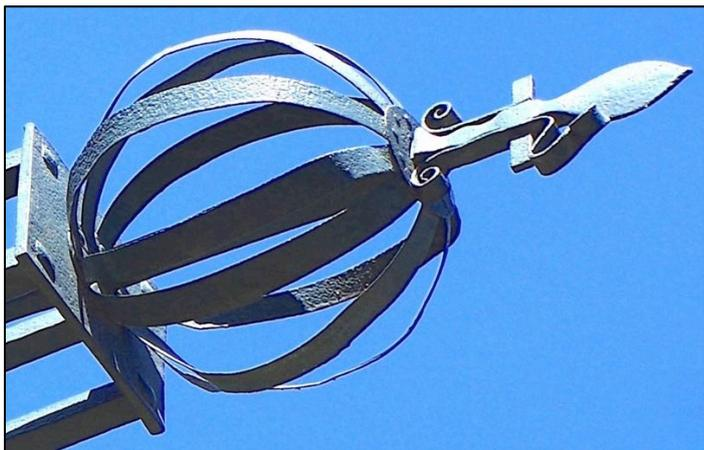
La barre centrale est progressivement amincie, forgé et découpé de façon à former finalement la graine saillante du fleuron d'extrémité. Celui-ci, s'apparente à une sorte de lis stylisé.
