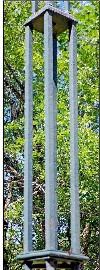
Les quatre fers montants du pied croisillon sont fixés à ue. petite platine carrée, de moindre dimension que la platine du sommet du fût-allonge. La moulure en quart-de-rond permet de rattraper cette différence de dimension. On note sur le cliché (en vue au téléobjectif ) le dispositif de fixation du décor central du pied du croisillon.
