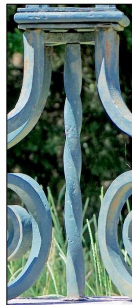
Au centre du dispositif, une tige de fer torsadée, scellée dans le tailloir en pierre, monte jusqu'à la platine de liaison et se fixe dans le dispositif de liaison et d'entretoisement en X. Elle ne se prolonge pas à l'étage supérieur mais contribue à la stabilisation de la croix. Plusieurs croix FF3D-ALS comportent de telles barres torsadées au centre du tabouret (Syam, Chaux-des-Crotenay, Entre-deux-Monts, Foncine-le-Bas, Foncine-le-Haut)
