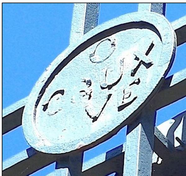
Deux disques en fer étampé à bord relevé occultent le dispositif d'assemblage et comportent les deux inscriptions religieuses traditionnelles (INRI et O CRUX AVE). Les lettres sont en tôle découpée, fixées en surélévation par rapport au disque, grâce à de petits picots-supports. On relève un dispositif similaire à Chaux-des-Crotenay (1826) et Entre-deux-Monts (1826).
