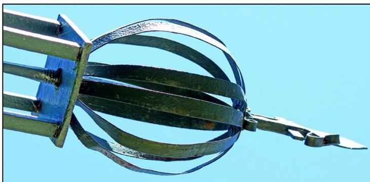
Les arceaux sont rivetés sur de petits disques en tôle traversés par la barre centrale.
