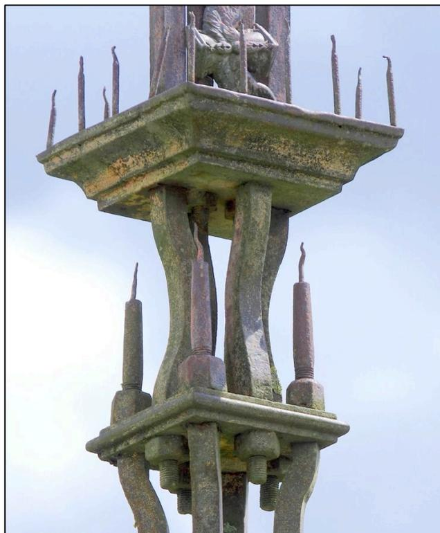
Les fers sont positionnés sur les milieux des côtés de la platine 3 de liaison avec le fût haut, avec leurs faces parallèles aux axes principaux de la croix.
