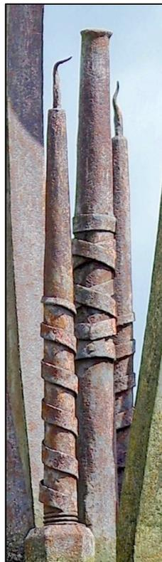
Dans la partie basse du fût, quatre nouveaux cierges à ruban spiralé montent des quatre angles de la platine 2 entre les deux fûts. Comme plus bas, ils sont solidement fixés à la platine 2 par de gros boulons à tête hexagonale chanfreinée, servant aussi à fixer les montants du fût bas.
