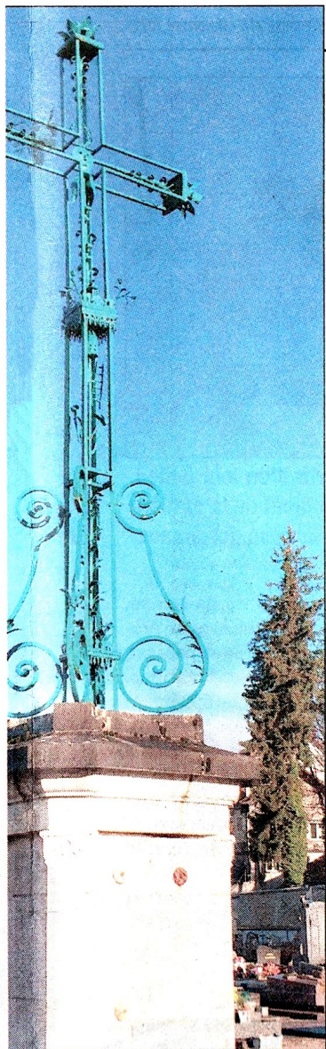
En fer forgé, la croix du cimetière a été rénoverée en 1859 et équipée pour l'occasion
