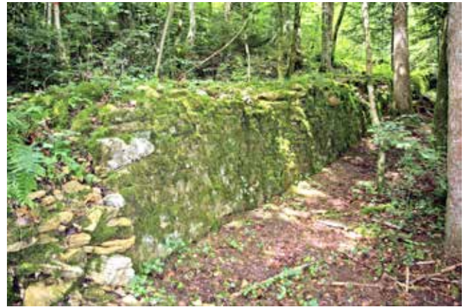
Mur militaire de la Grange d'Aufferin
