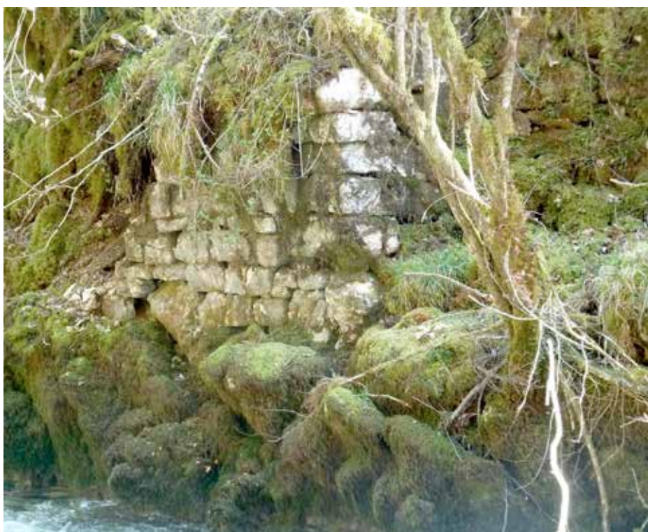
Seul vestige conservé du Pont d'Enfer sa culée en rive gauche de la Saine
