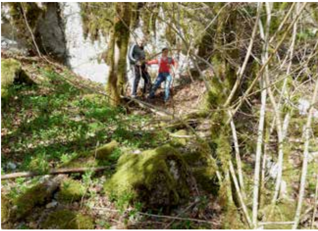
Sous la falaise, les éboulis, le chemin détruit
