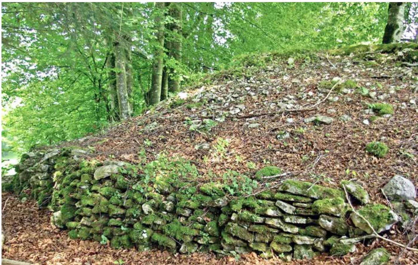
En bas de la combe de Crans, le mur désigné par les équipes Berthier "mur Girard" s'étire en bas du relief en épousant sa forme. Il est constitué d'un parement qui retient un grand volume de matériaux de remplissage, ce qui lui donne un aspect massif et puissant.
