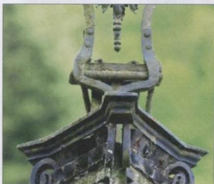
Ainsi, la barrette terminale de la branche inférieure du croisillon est portée par deux puissants potelets cylindriques la reliant au chapiteau. Elle est aussi insérée, prise comme en tenaille, dans un double système de fixation avec un étrier sur une des faces et deux fers obliques complémentaires sur l'autre face.
