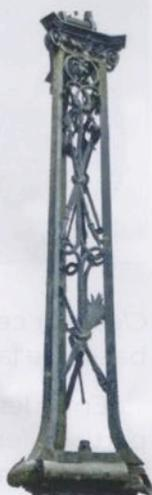
Le décor en tôle de fer repoussée représente des instruments de la Passion du Christ et d'autres symboles religieux. Il se répartit sur deux niveaux ou étages de la colonne-fût. Tous ces éléments de décor en tôle de fer sont fixés par de discrets rivets aux montants structurels de la colonne-fût.
