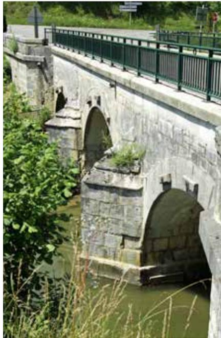
On ne voit pas le dessous des voûtes des arches, mais il semble que l'on ait gardé les anciennes voûtes. Les tympons ou joues au-dessus des arches sont récentes (années 80) et ont été réalisés avec un appareil qui donne l'allure d'un pont médiéval. Une dalle en béton armée, à profil horizontal, a été réalisée pour soutenir la chaussée.
